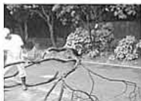
住之江公園での雑木伐採作業
